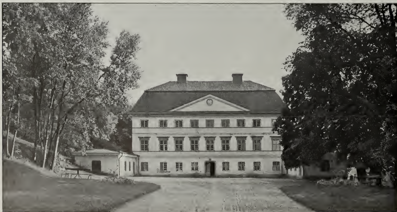
Fasaden åt gårdssidan.
